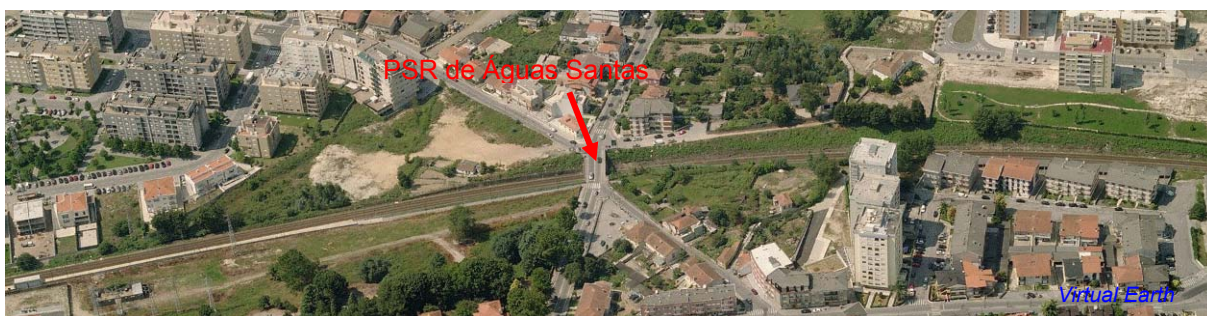
Figura 3.1.15 - Passagem Superior Rodoviária ao km 7+025
