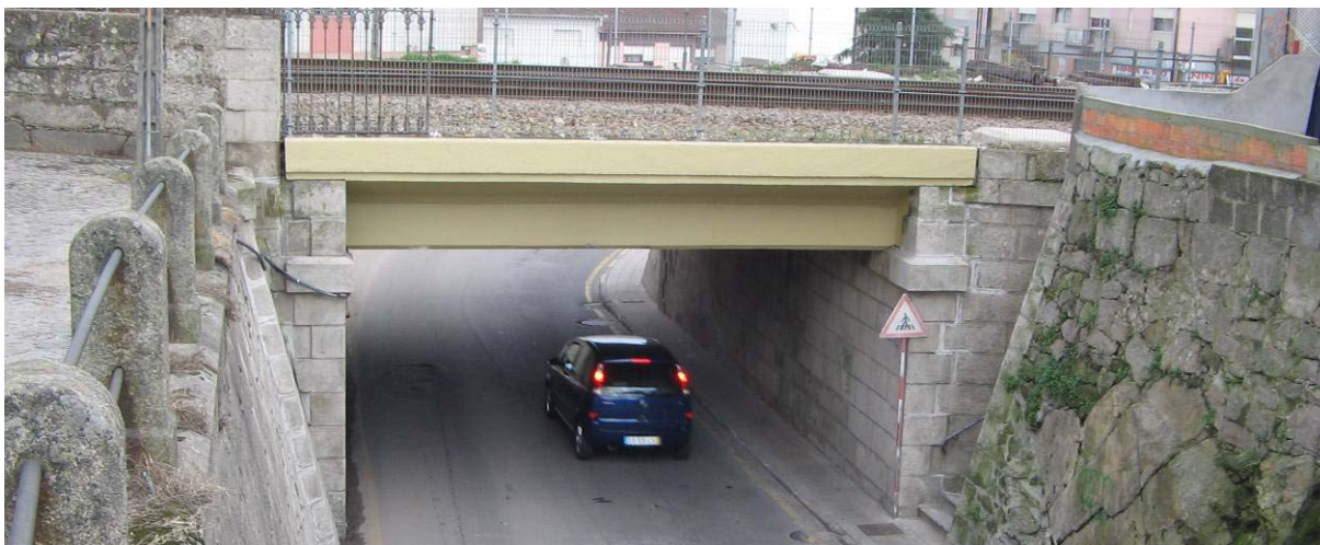
Figura 3.2.14 - Estação de Rio Tinto, Passagem Inferior Rodoviária
