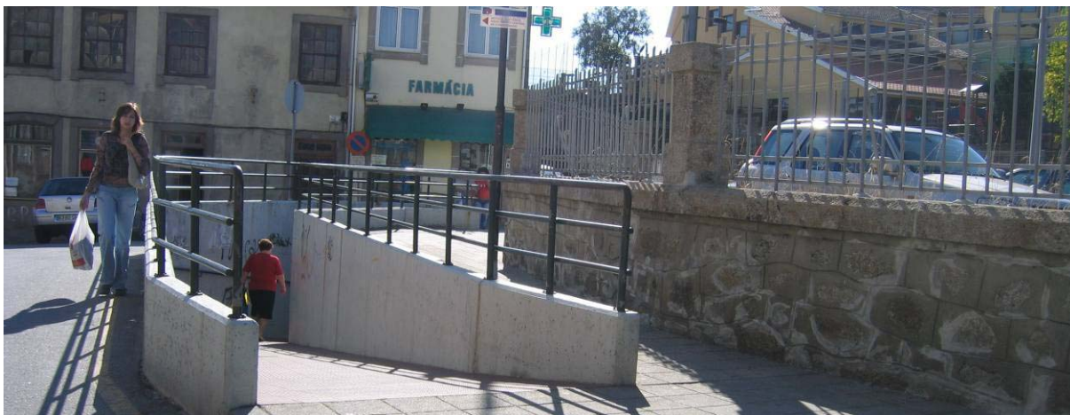
Figura 3.2.11 - Passagem Inferior Pedonal na zona sul da Estação de Rio Tinto
