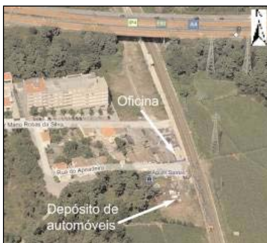
Figura 5.3.1 - Oficina e depósito de automóveis
