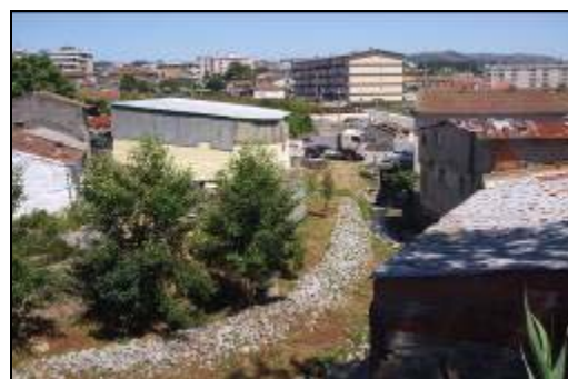
Figura 4.10.13 - Vista sobre o leito do rio Tinto
