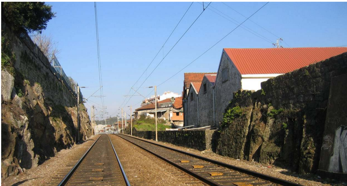
Figura 3.3.1 - Talude junto ao Externato Camões – km 4+400 a 4+575
