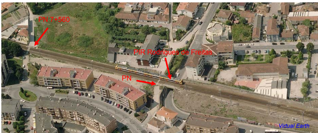
Figura 3.1.17 - Zona entre a PN ao km 7+560 e a entrada na Estação de Ermesinde
