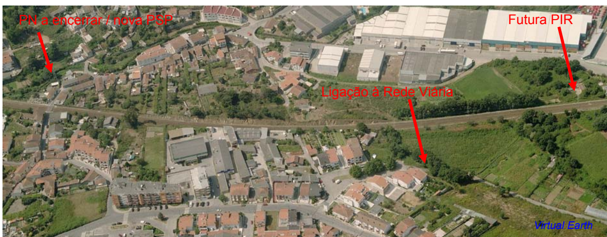
Figura 3.1.10 - Zona Norte da Estação de Rio Tinto, entre a PN e a futura Passagem Inferior Rodoviária
