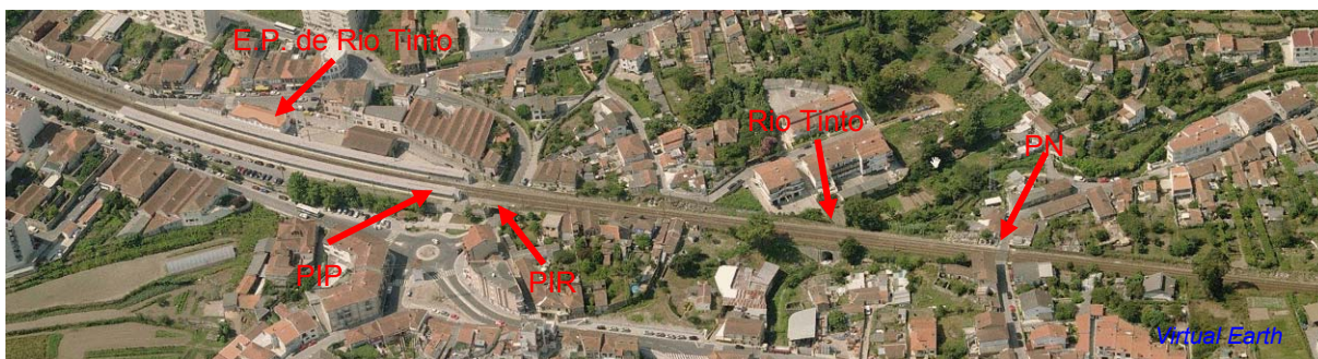
Figura 3.1.9 - Zona Norte da Estação de Rio Tinto
