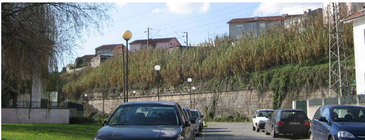
Figura 3.2.6 - Passagem Inferior Rodoviária da Conduta – km 3+865
