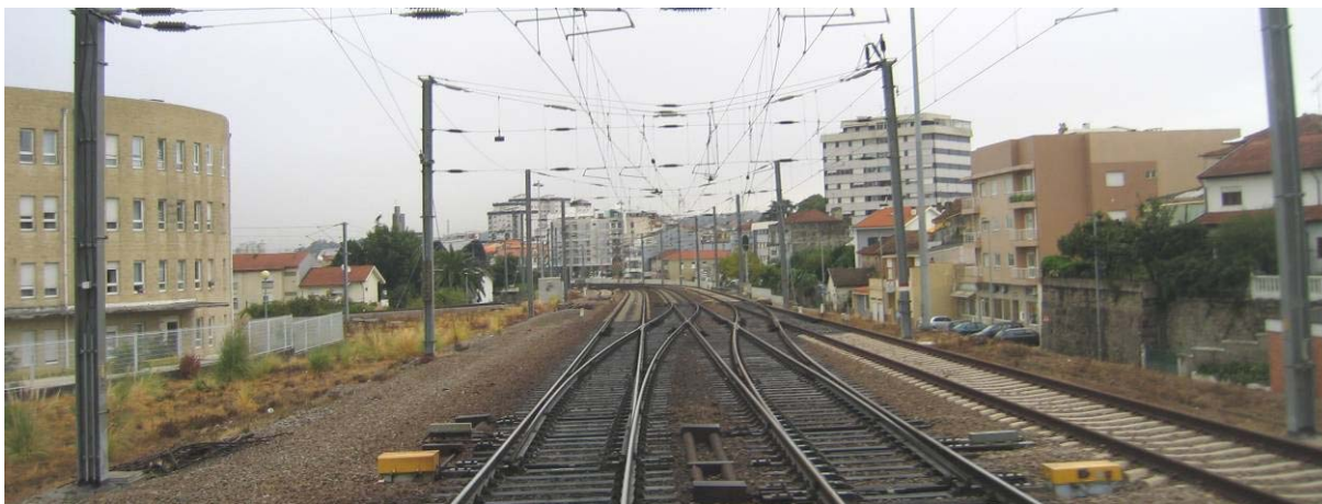
Figura 3.3.4 - Entrada Sul da Estação de Ermesinde (fim do troço em estudo)
