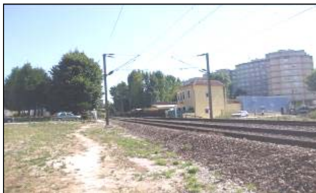
Figura 4.10.22 - Vista da área urbana existente na zona final do troço
