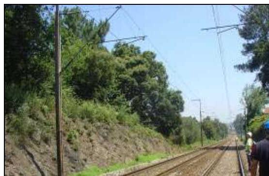
Figura 4.10.7 Vista dos taludes de escavação na zona inicial do troço
