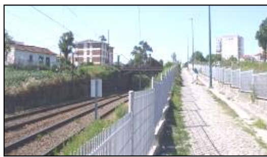
Figura 4.10.21 - Passagem Superior Rodoviária ao km 7+025
