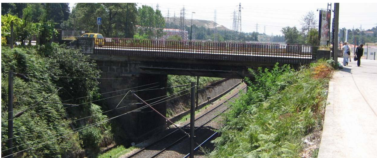
Figura 3.1.14 - Passagem Superior Rodoviária ao km 7+025 (Vista Norte / Sul)
