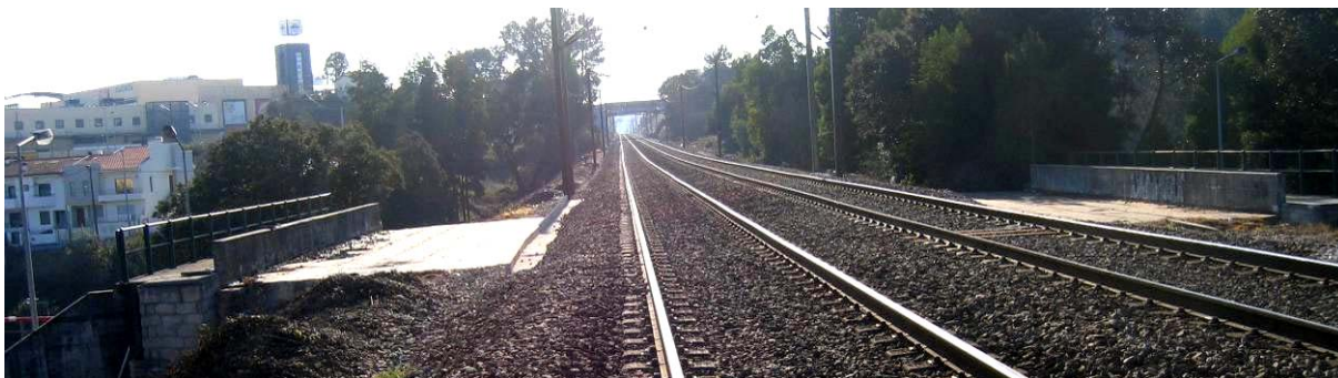
Figura 3.2.3 - Passagem Inferior Rodoviária da Conduta – km 3+865
