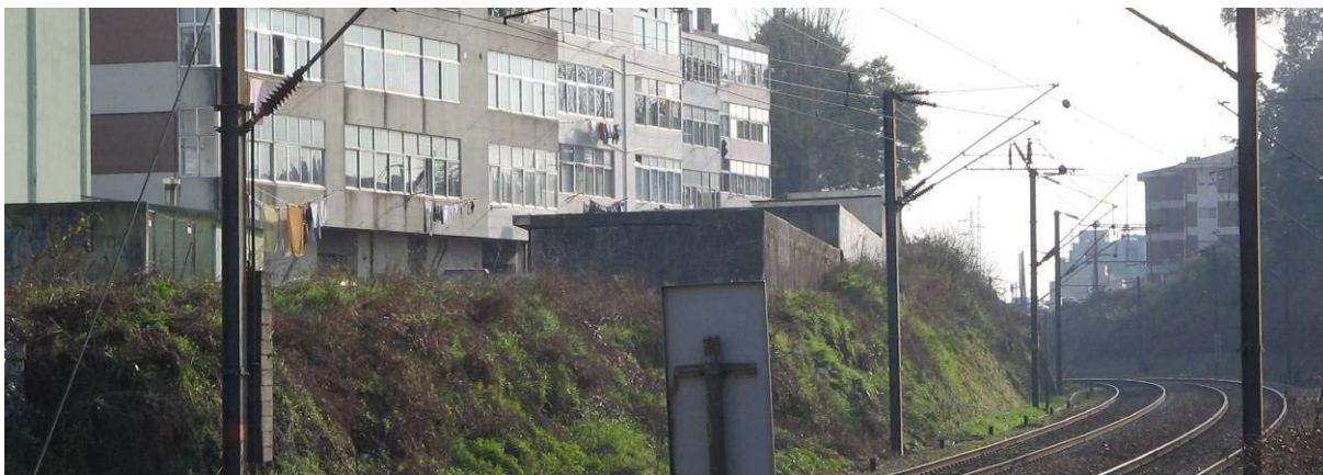
Figura 3.2.30 - Garagens ao km 7+300
