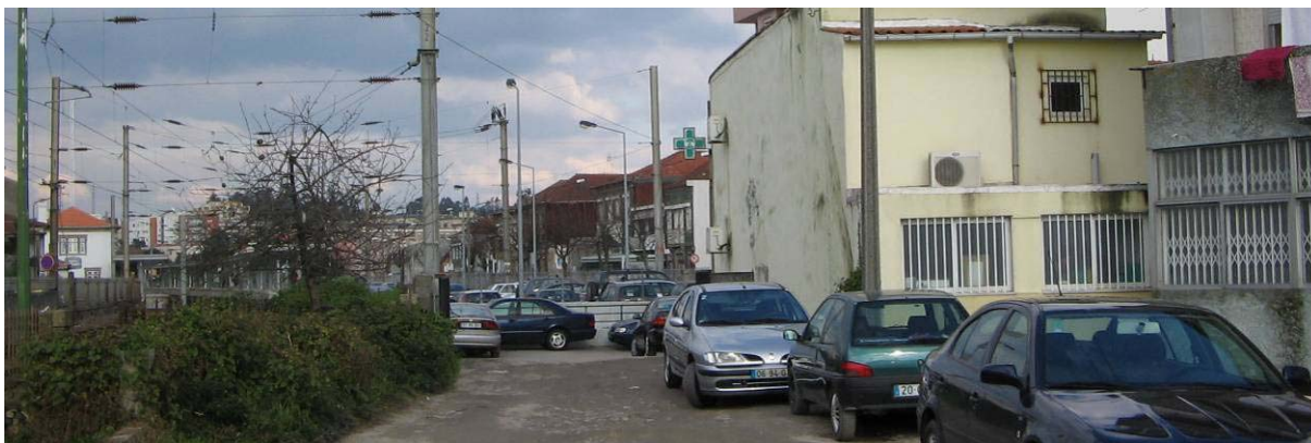
Figura 3.2.10 - Estação de Rio Tinto – Zona de acesso aos Armazéns
