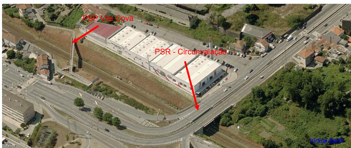
Figura 3.1.4 - Estrada da Circunvalação / Conduta
