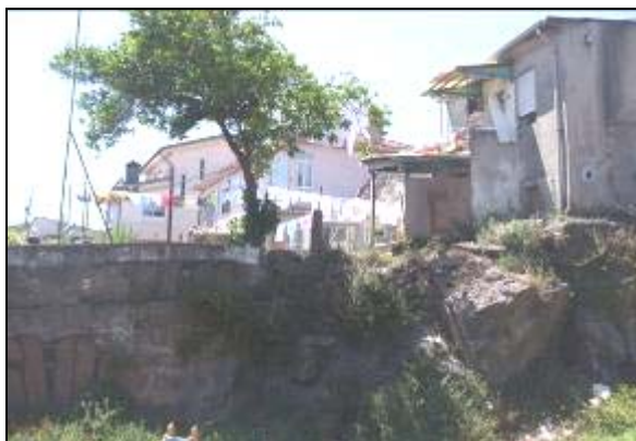
Figura 4.10.1 - Área urbana degradada próxima da PSP existente ao km 3+388
