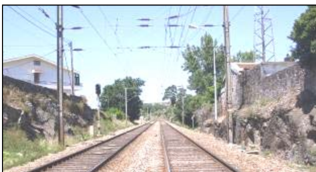
Figura 4.10.12 - Enquadramento da via na zona imediatamente após a estação de Rio Tinto
