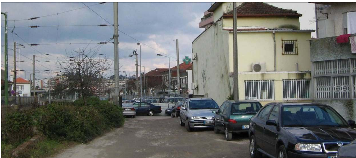
Figura 3.3.2 - Edifícios situados do lado direito da via, à entrada de Rio Tinto
