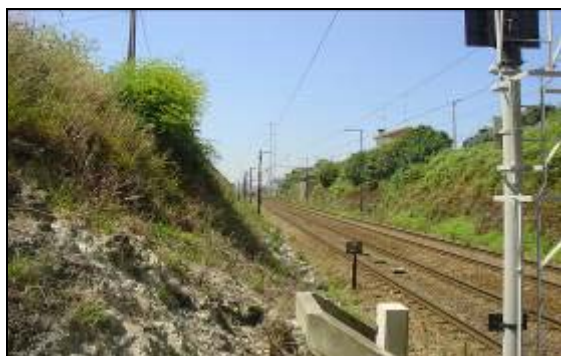
Figura 4.10.6 - Vista dos taludes de escavação na zona inicial do troço
