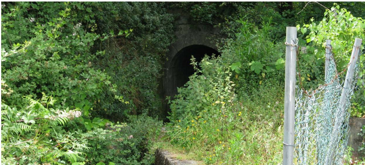
Figura 3.2.2 - Passagem Hidráulica ao km 3+800
